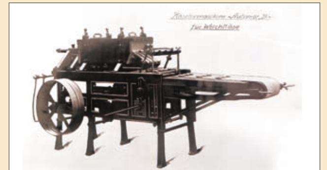
Käseformmaschine Automat „B“ für Weichkäse (1910)
