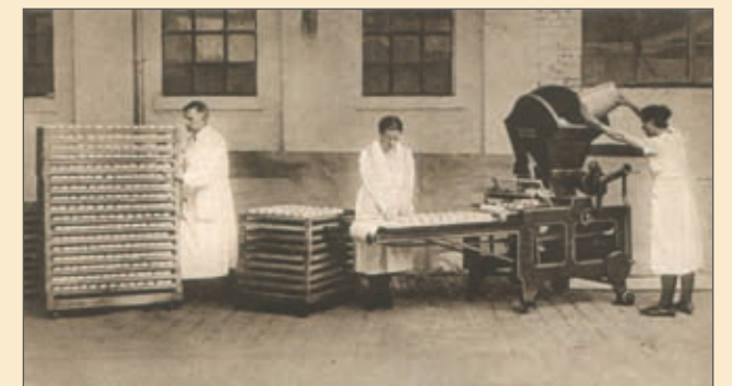
Käseformmaschine Automat „D“ (1920)
