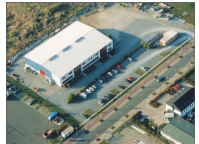
Das neu errichtete Firmengebäude (1994)
